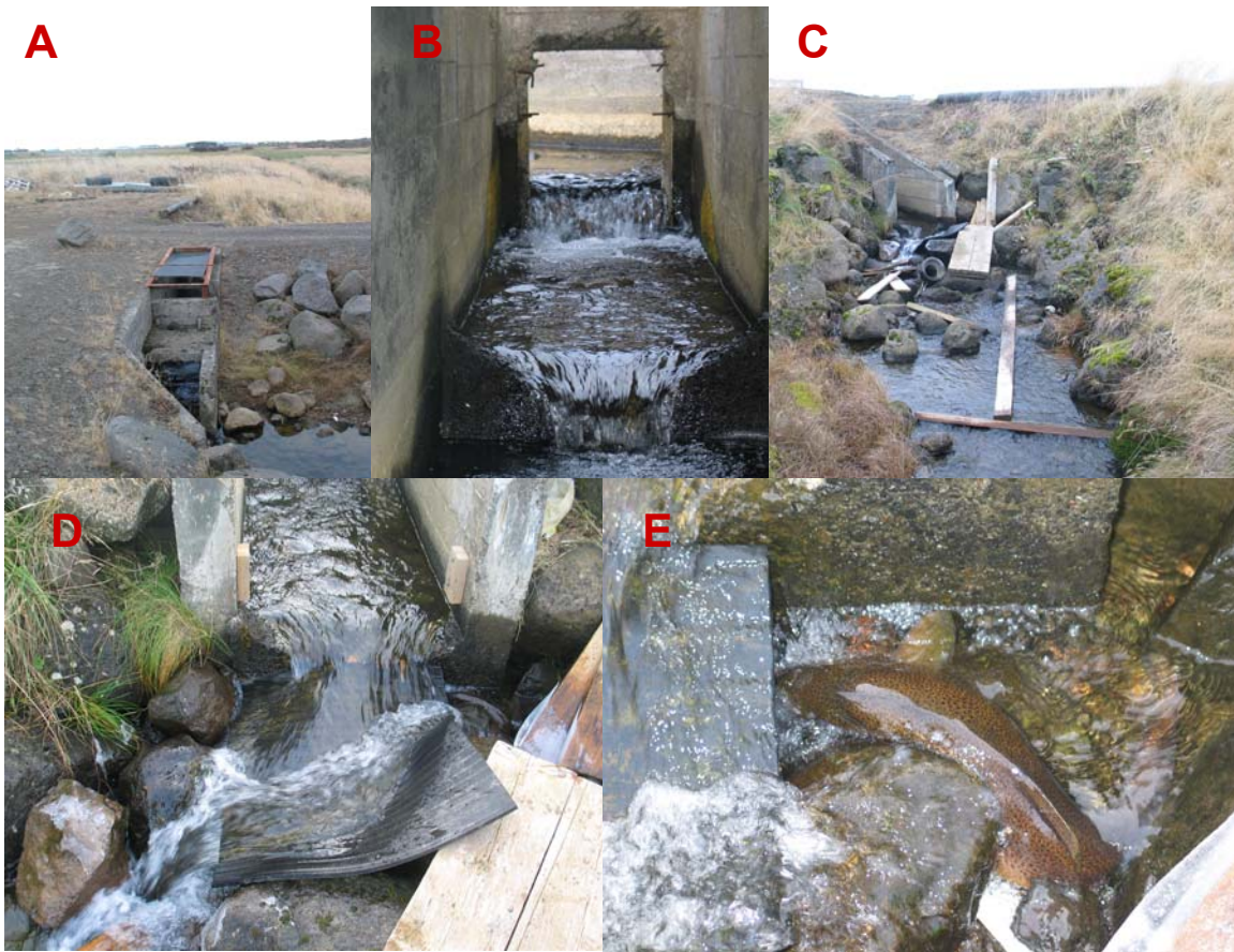
Mynd 12. Stokkur/hindrun í Stórákrókslæk. A) stökkurinn séður ofan frá. B) séð upp í gegnum stökkinn. C) stökkurinn séður neðan frá. D) útfall úr stökknum. E) hrygningarurriði í ógöngum fyrir neðan stökkinn.
